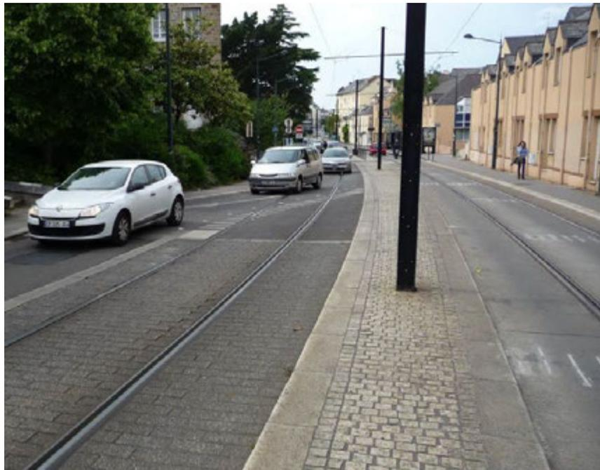
**Photo 6.11 Exemple d'un partage de la plateforme (site banal)**
